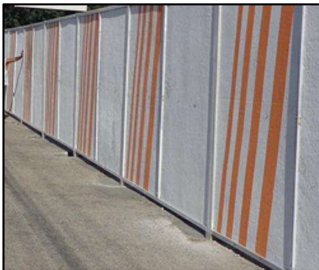
Imagem: Tapume de Compensado h=2,00m
